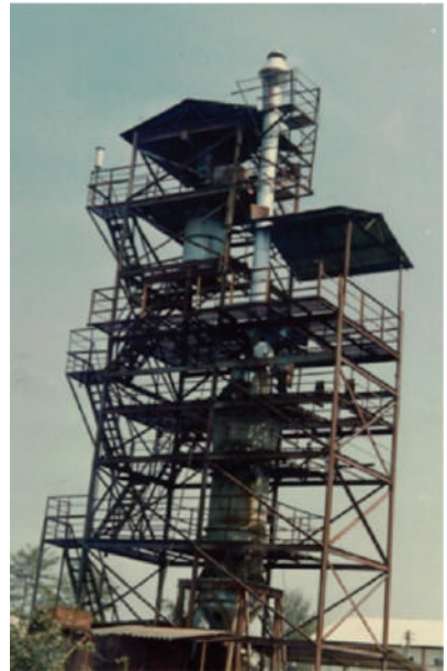
VSK Mini cement plant of CSIR-NEIST
